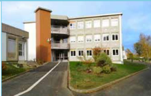
Travaux d'accessibilité et de rénovation énergétique au collège Saint-Exupéry à Éguzon
