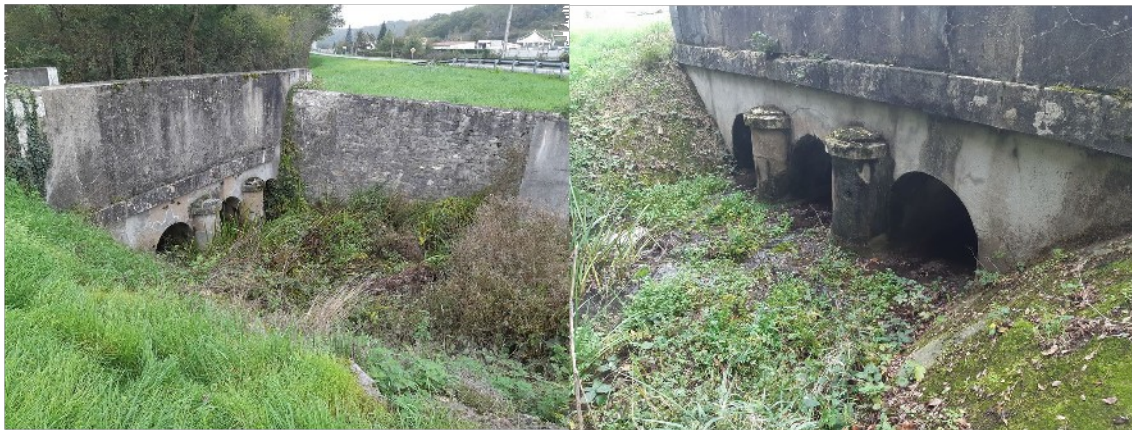
Pont de l'ancienne D951, vue amont puis aval
